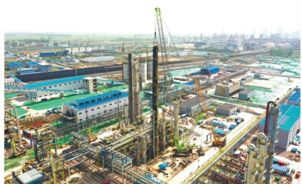
5月5日，一分公司、机械化分公司承建的安徽淮北碳纤维科技焦炉煤气综合利用项目大型设备甲醇洗涤塔上段顺利吊装完成。至此，项目
